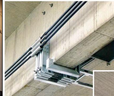
Nachträgliche Anordnung von externen Spanngliedern SUSPA-Draht EX
