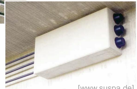
Nachträgliche Anordnung von externen Spanngliedern SUSPA-Draht EX
